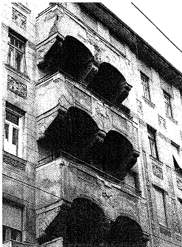
1.sz. kép: Népszínház utca felőli, 2-4. emeleti erkélyek.
