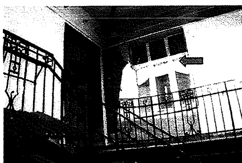
A lakás bejárata, ablak
