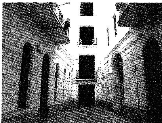
Társasház udvari homlokzata
