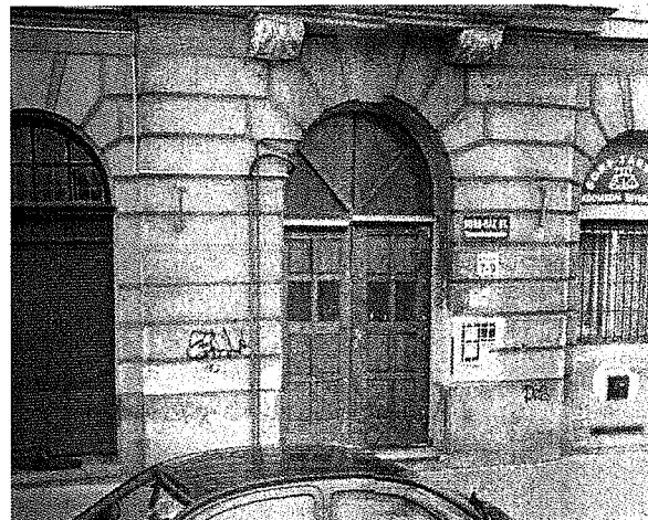
A társasház bejárata
