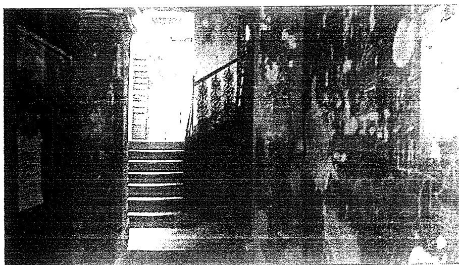
kapualj földéme és a fölépcsőház bejárata
