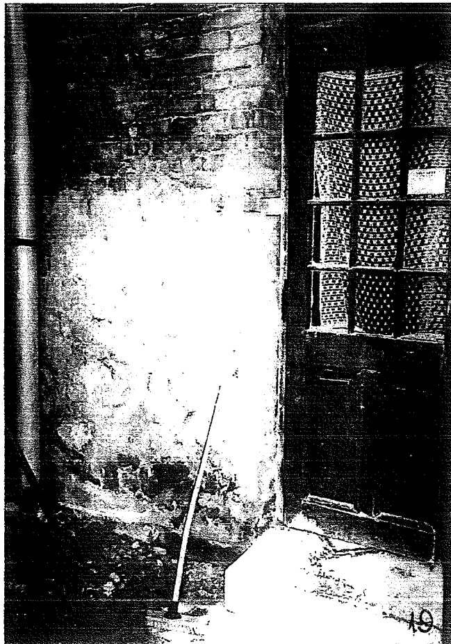
földszinti közös WC bejárata
