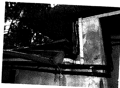
homlokzat részlet, hibás esővíz elvezetés
