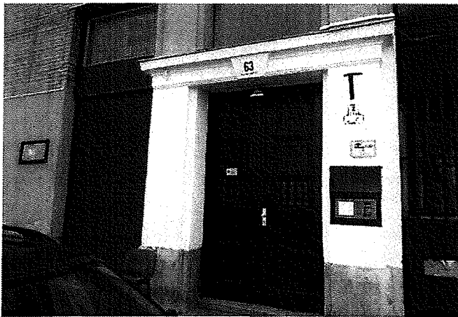
Épület bejárata, jobbra helyiség bejárata
