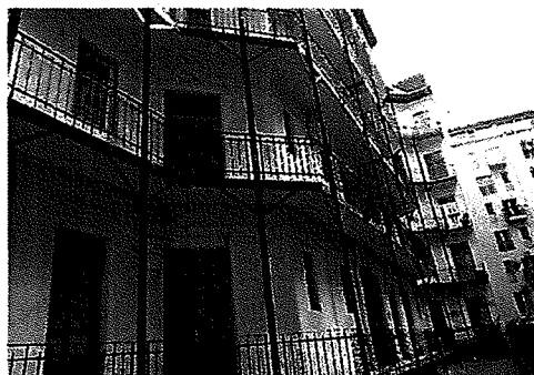
udvari homlokzat részlet
