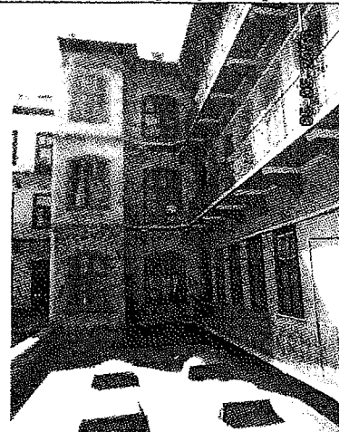
06 A lakóház udvari látképe
