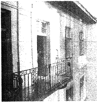
Vizsgált ingatlan udvari homlokzata
