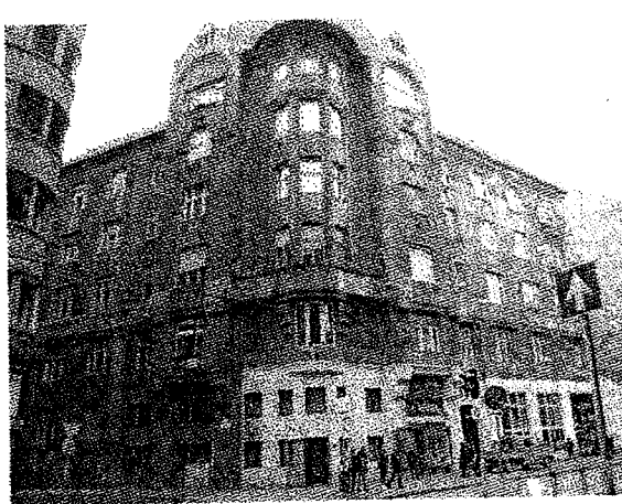
A társasház utcai homlokzata
