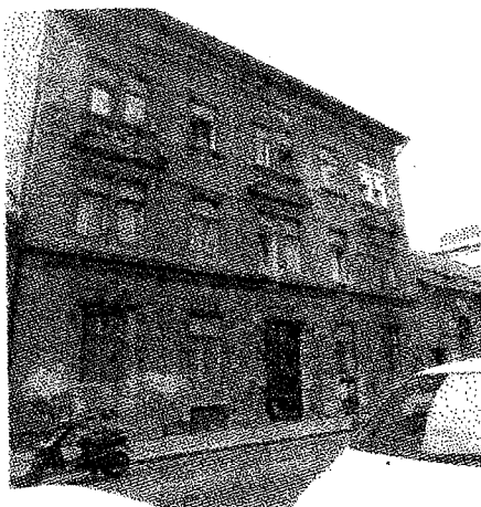
A társasház utcai homlokzata
