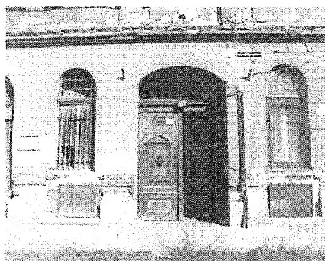
A társasház bejárata
