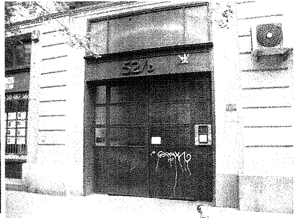
A társasház bejárata
