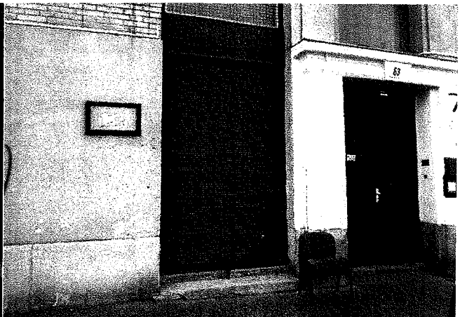
Épület bejárata, jobbra helyiség bejárata
