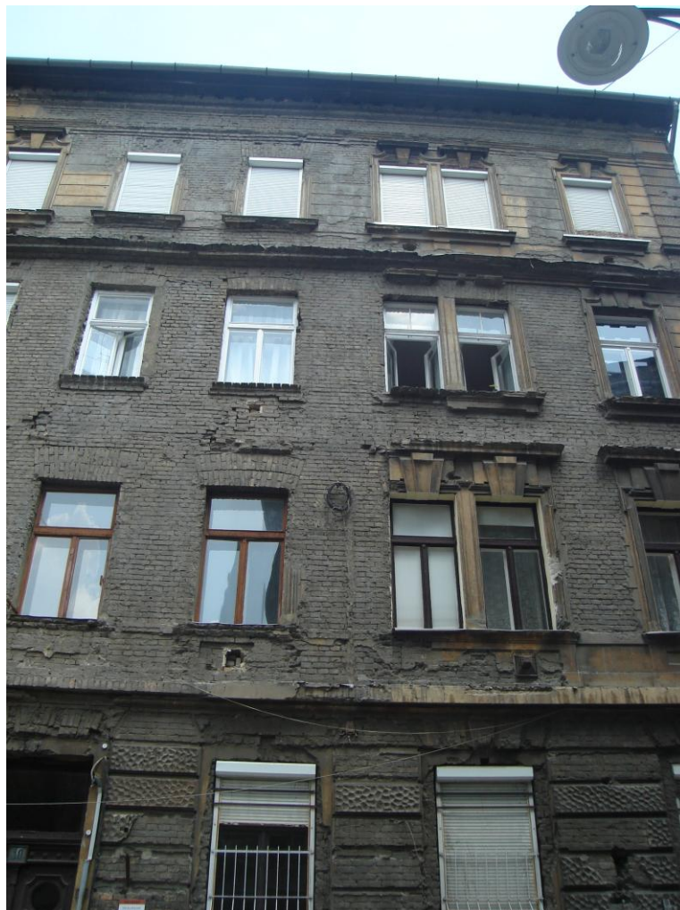
Falazathibák, homlokzati díszek, ereszalj, fogsor helye, fa kapcsolt gerébtokos ablakok
