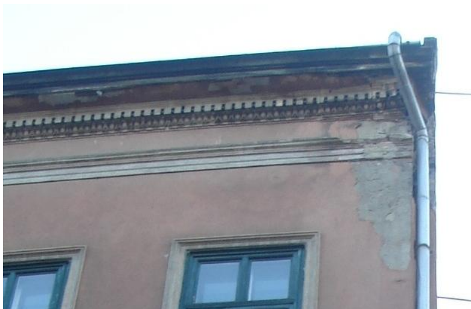
Tojásléc, fogsor, ereszalj, lefolyócső a homlokzat jobb oldalán
