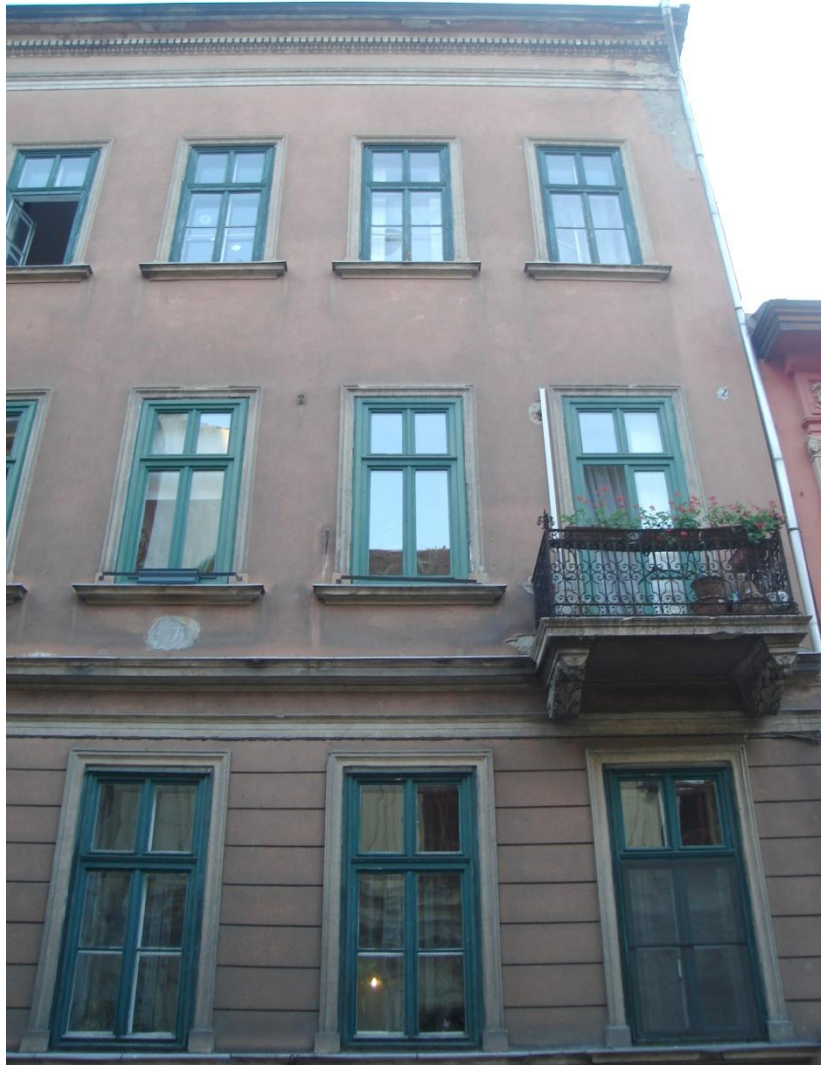
Homlokzat általános felülete
