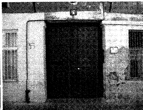
A társasház bejárata
