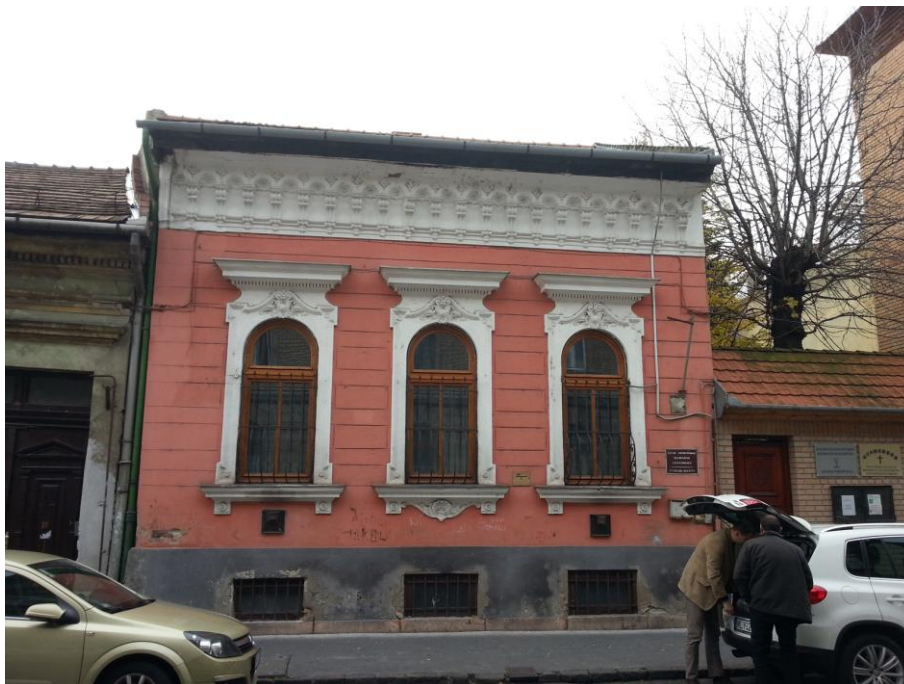
1. Felújítással érintett utcai homlokzatrész
