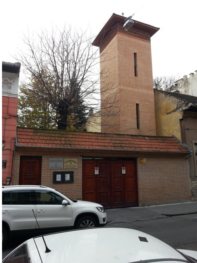
2. Csatlakozó kerítésfál és templomtorony
