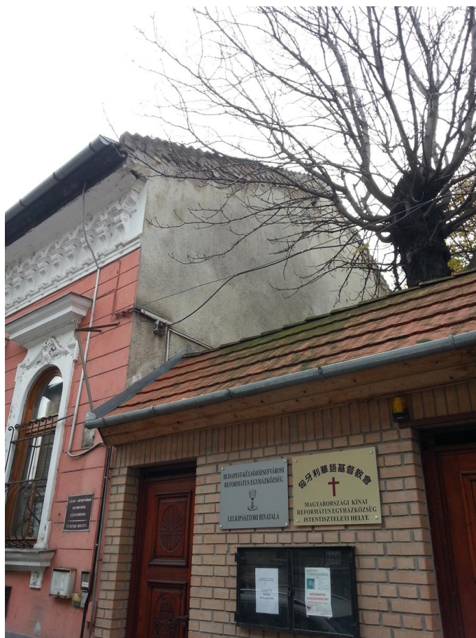
9. Tűzfal, nyugati homlokzat
