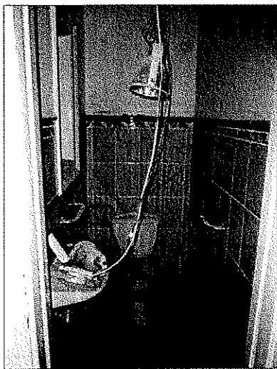
WC, leszakadt álmennyezet
