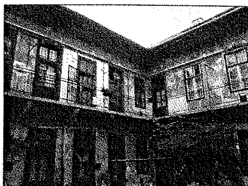
Udvari homlokzat, függőfolyosó
