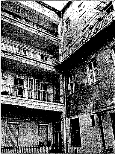
Udvari homlokzat, függőfolyosók
