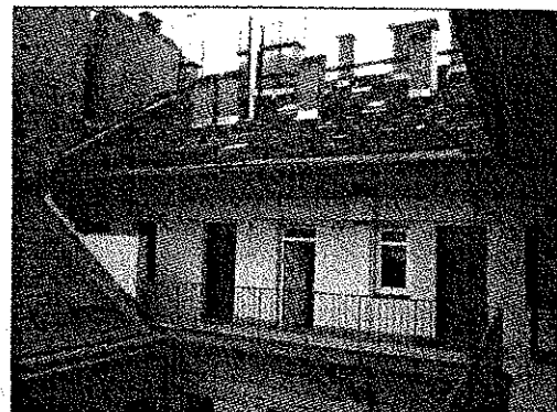
Tető héjalás, kémények
