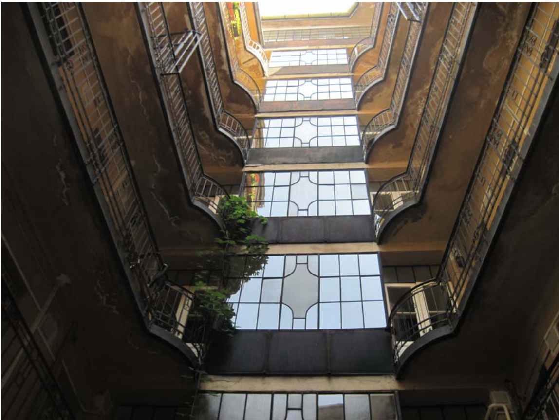
meglévő állapot, korrodált fémszerkezetek
