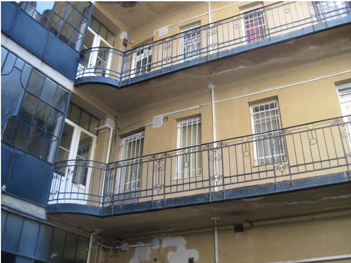
meglévő állapot, korrodált fémszerkezetek
