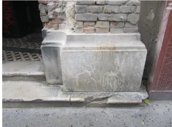
Lábazat a jobboldali rizalitnál, teljesen hiányzó alsó profil, kisebb-nagyobb kitörések. Csatorna melletti felső táblán sarokirányú repedés, a jobboldalin hálós repedezettség
