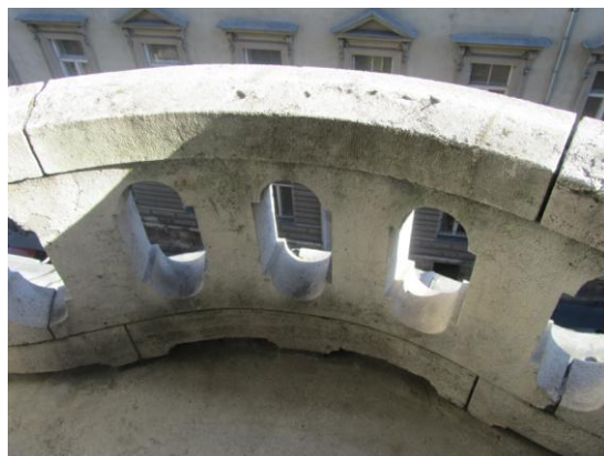
A jobboldali erkély mellvédje: kis kitérések, szerves szennyeződés, fugahiány
