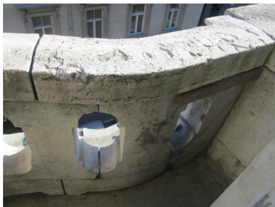
A jobboldali erkély mellvédje: kis kitérések, szerves szennyeződés, fugahiány
