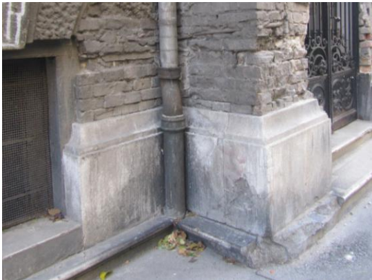
Lábazat a jobboldali rizalitnál, teljesen hiányzó alsó profil, kisebb-nagyobb kitörések. Csatorna melletti felső táblán sarokirányú repedés, a jobboldalin hálós repedezettség
