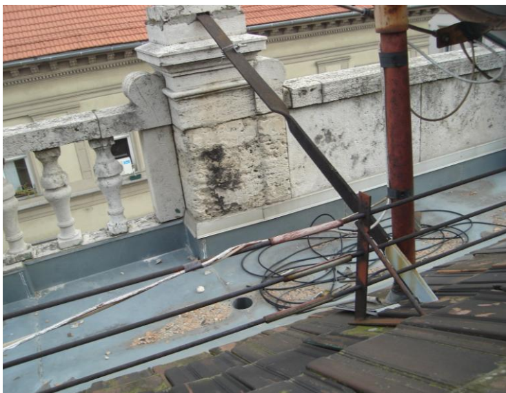
A jobboldali rizalit melletti lefolyó környezete, és a másodlagosan rögzített vázadísz
