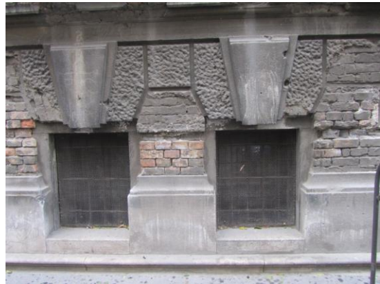
Ép lábazatszaksz és pinceblyak keretek csak kis kitörések, élcsorbulások
