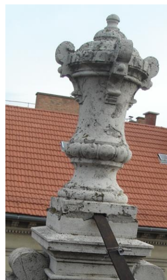
A jobboldali rizalit melletti lefolyó környezete, és a másodlagosan rögzített vázadísz
