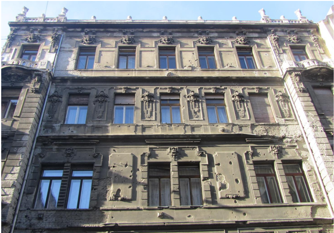
Az első, második és a harmadik emelet homlokzata a rizalitok között
