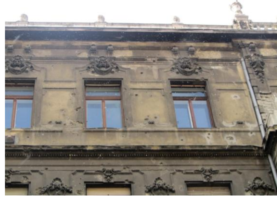
A harmadik emelet homlokzata
