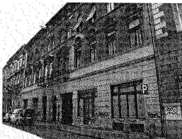
A társasház utcai homlokzata
