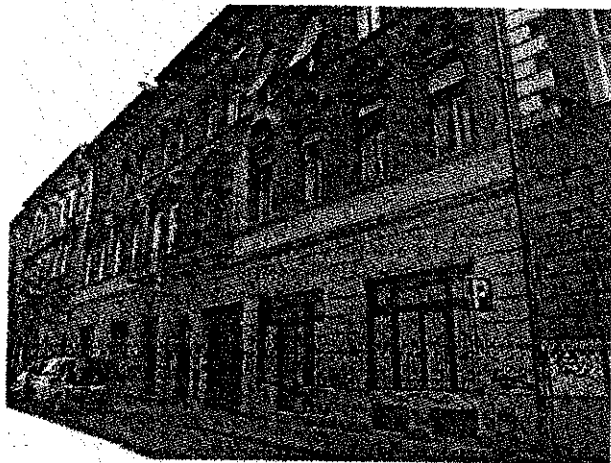
A társasház utcai homlokzata
