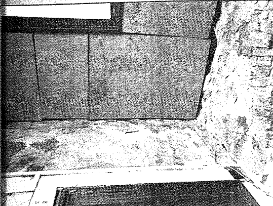
Széldeszkmázat helyett farost lemez
