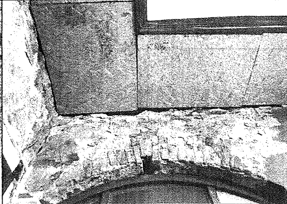
Széldeszkmázat helyett farost lemez
