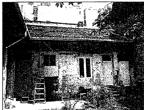
Bal oldali szárny és pince lejárát
