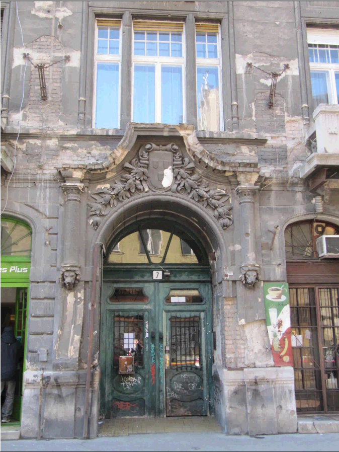
AZ ÉPÜLET KAPUBEJÁRATA
