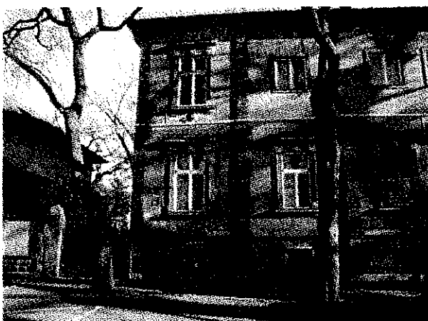
A társasház utcai homlokzata
