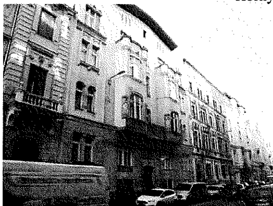
A társasház utcai homlokzata
