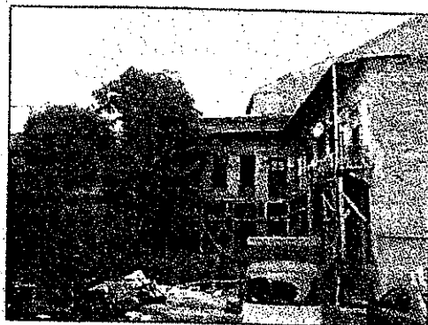
Udvari homlokzat, függőfolyosó aládúcolás
