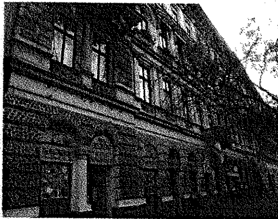
A társasház utcai homlokzata
