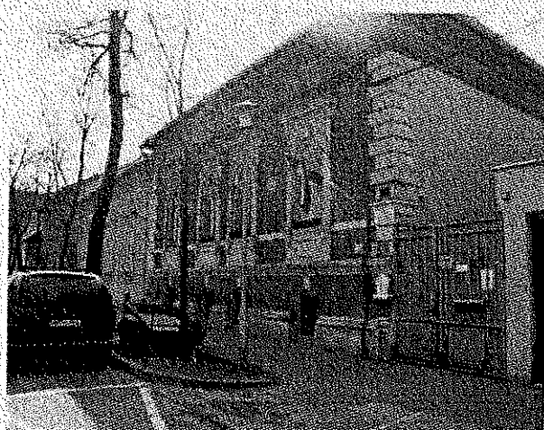
A társasház utcai homlokzata
