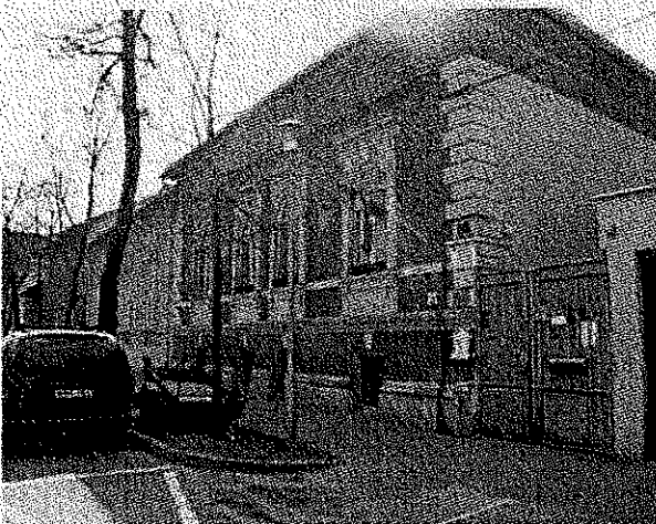
A társasház utcai homlokzata
