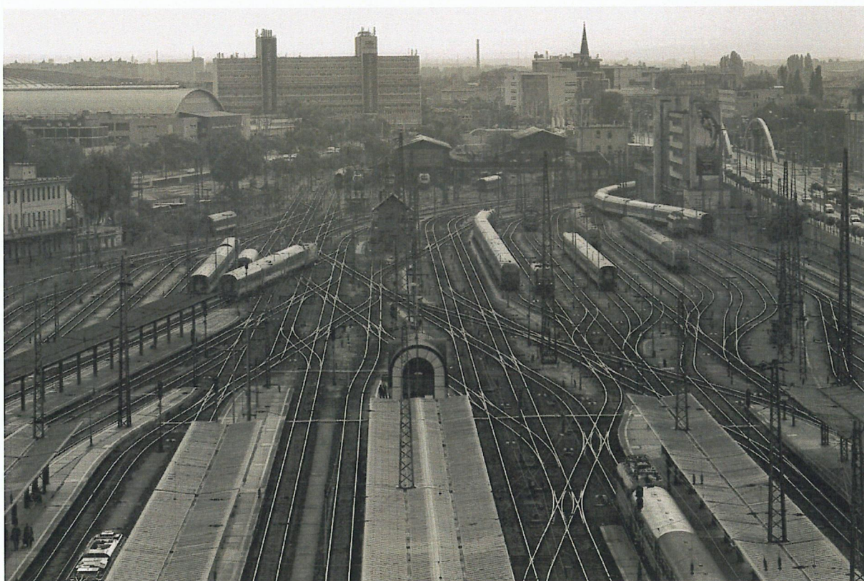
Keleti Pályaudvar - Perontetők, 2. Torony, PFT épület, 1. Fűtőház, 2. Fűtőház
