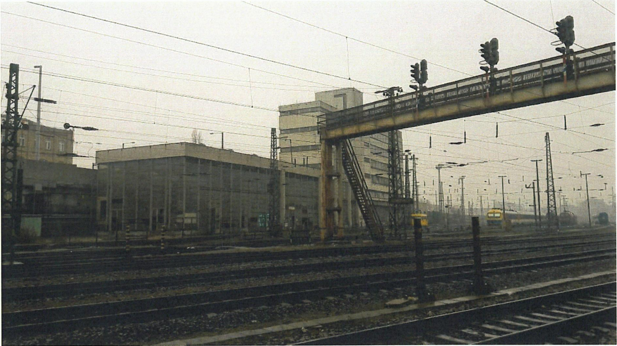
Keleti Pályaudvar - PFT épület és Kazánház a vágányok felől
