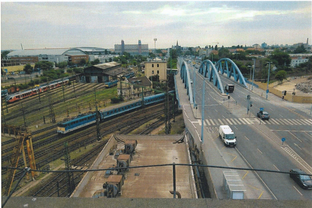
Keleti Pályaudvar - Kerepesi úti híd környezete, Fürdő, Forgalomirányítás épülete, 2. Fűtőház
