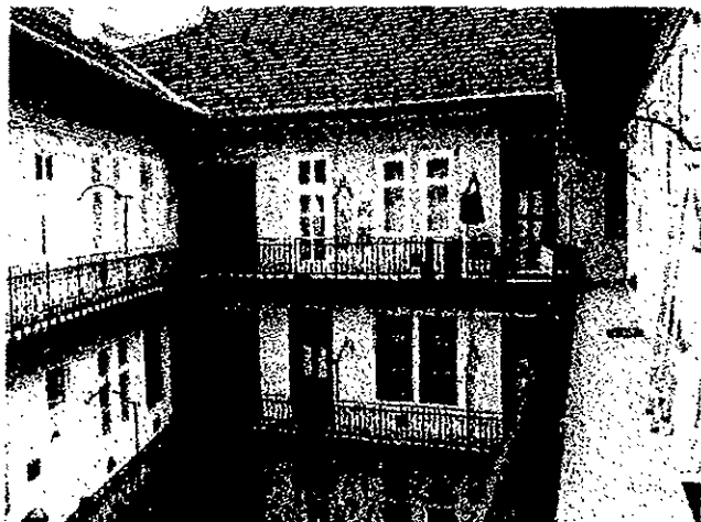
04. belső homlokzat, tetőszerkezet
