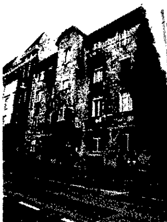
A társasház utcai homlokzata
