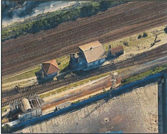
A jelenlegi, bontandó épületet
