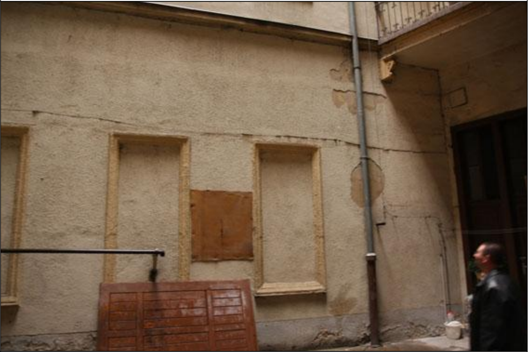
A belső udvar és a belső homlokzatok.
