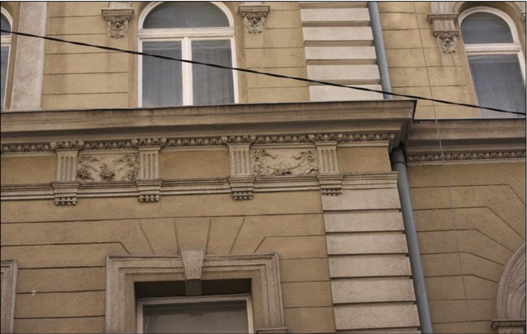
A 2. osztópárkány a Kölcsey utcai homlokzaton.
