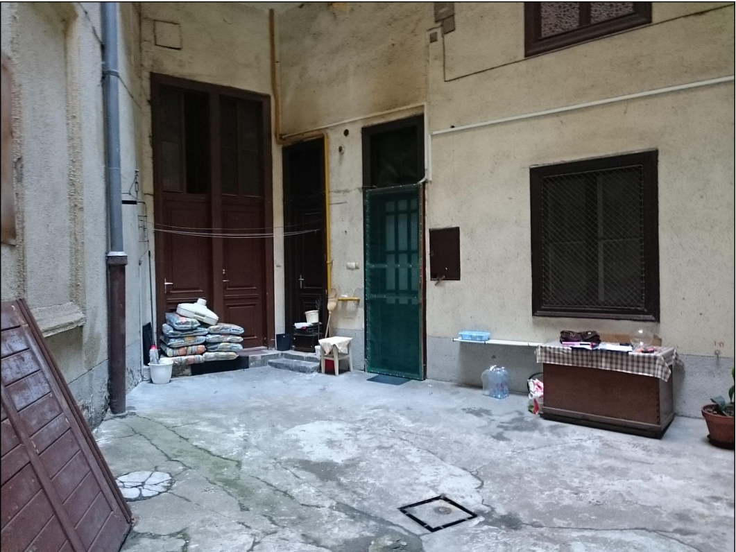
A belső udvar és a belső homlokzatok.
