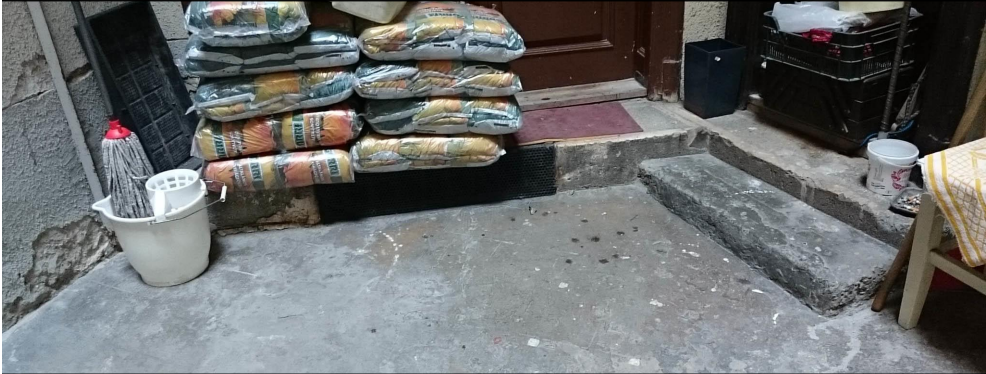
Meglévő kő fellépő pinceszellőzővel. Tisztítás, polírozás. A belső udvar hátsó bejárata előtti tömbkő fellépő.
