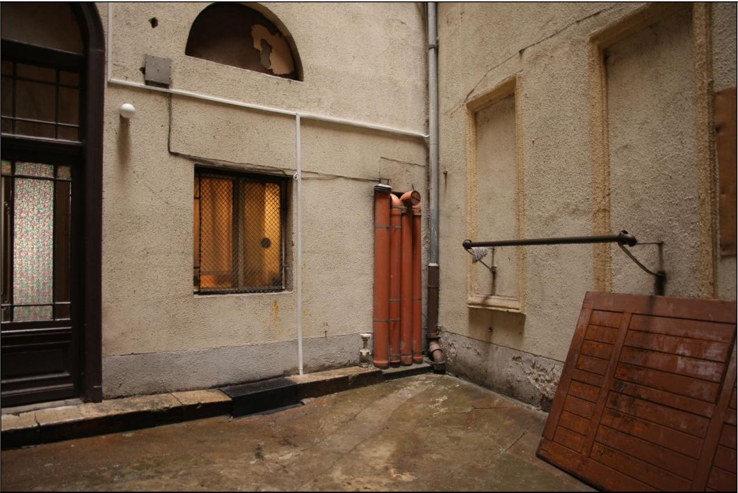
A belső udvar és a belső homlokzatok.
