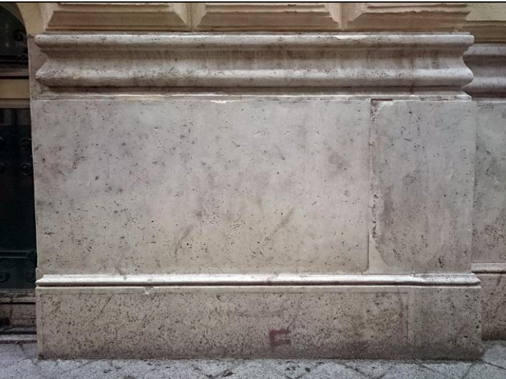
A süttői édesvázi eredtű keménymész-kő lábázat "használatban". A környéken fotózott mintafelület
