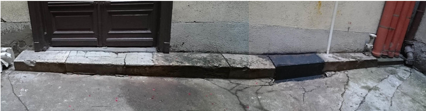
Bontandó kő/beton fellépő pinceszellőzővel. Új, vasalt beton fellépő lesz. A belső udvar bejárata előtti tömbkő/beton fellépő.
