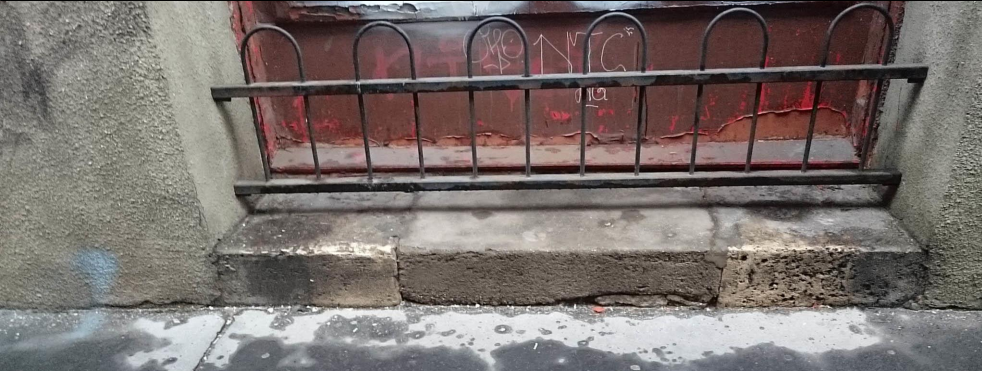
Meglévő kő fellépő. Tisztítás, polírozás, beton bontás. Középen új kő. Új, kovácsoltvas korlát készül. Békési utca, a József körút felőli 3. tengely (használt ruha bolt).
