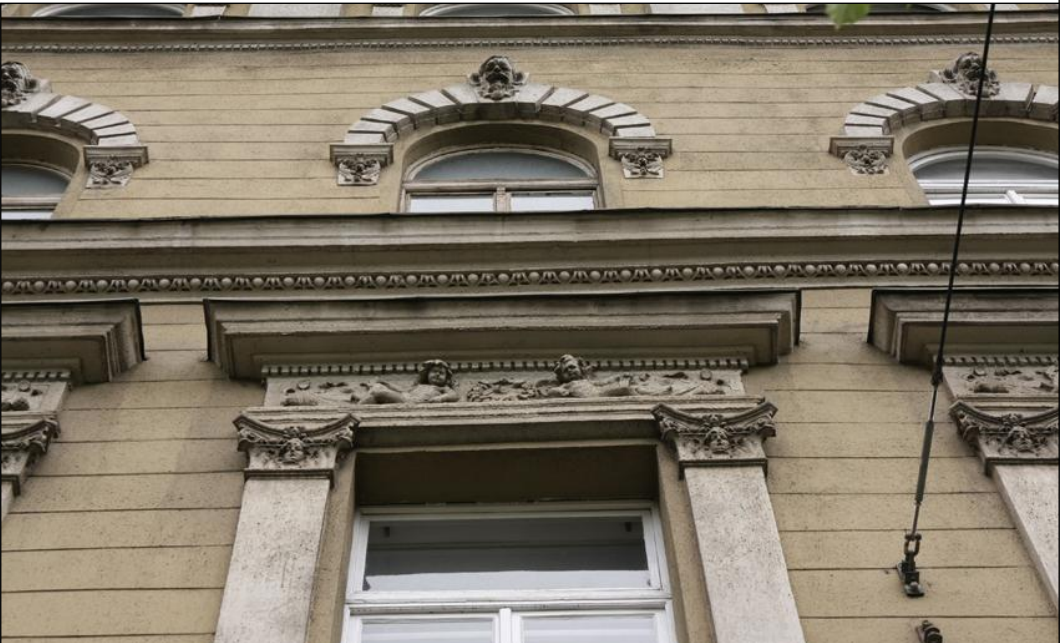
Az 1. emeleti nyíláskeretezés, szemöldökpárkány és a 2. osztópárkány a József körüti homlokzaton.
