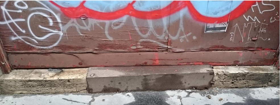
Meglévő kő fellépő pinceszellőzővel. Tisztítás, polírozás. Békési utca, a József körút felőli 4. tengely (használt ruha bolt).
