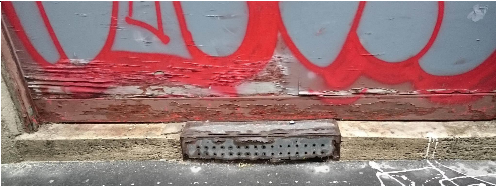
Meglévő kő fellépő pinceszellőzővel. Tisztítás, polírozás. Békési utca, a középső tengely (használt ruha bolt).
