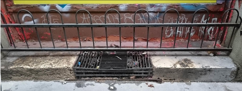
Meglévő kő fellépő pinceszellőzővel. Tisztítás, polírozás. Új, kovácsoltvas korlát készül. Békési utca, a József körút felőli 2. tengely (használt ruha bolt).
