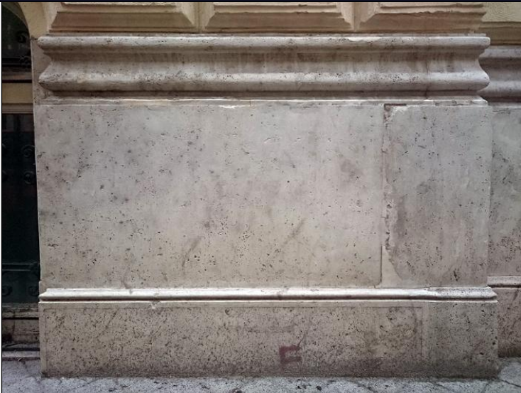
A süttöi édesvízi eredtű keménymész-kő lábazat "használatban". A környéken fotózott mintafelület
