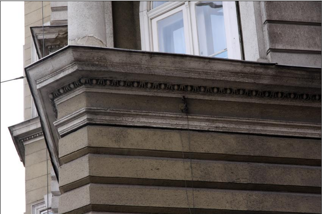
A kváderes homlokzat és az osztópárkány jellemző állapota.
