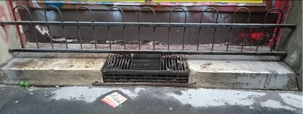
Meglévő kő fellépő pinceszellőzővel. Tisztítás, polírozás. Új, kovácsoltvas korlát készül. Békési utca, a József körút felőli 1. tengely (használt ruha bolt).
