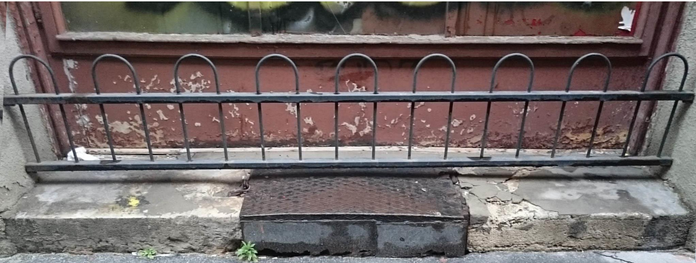
Új tömbkő fellépő, pinceszellőzővel. Új szerkezet lesz. Új, kovácsoltvas korlát készül. Békési utca, a Gutenberg tér felőli 4. tengely (használt ruha bolt).
