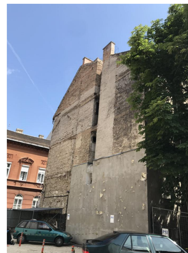
Tűzfal a tervezési terület felől
