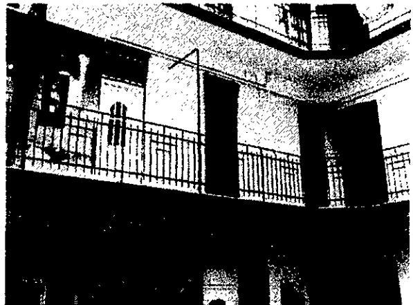
05. belső homlokzat, függőfolyosó
