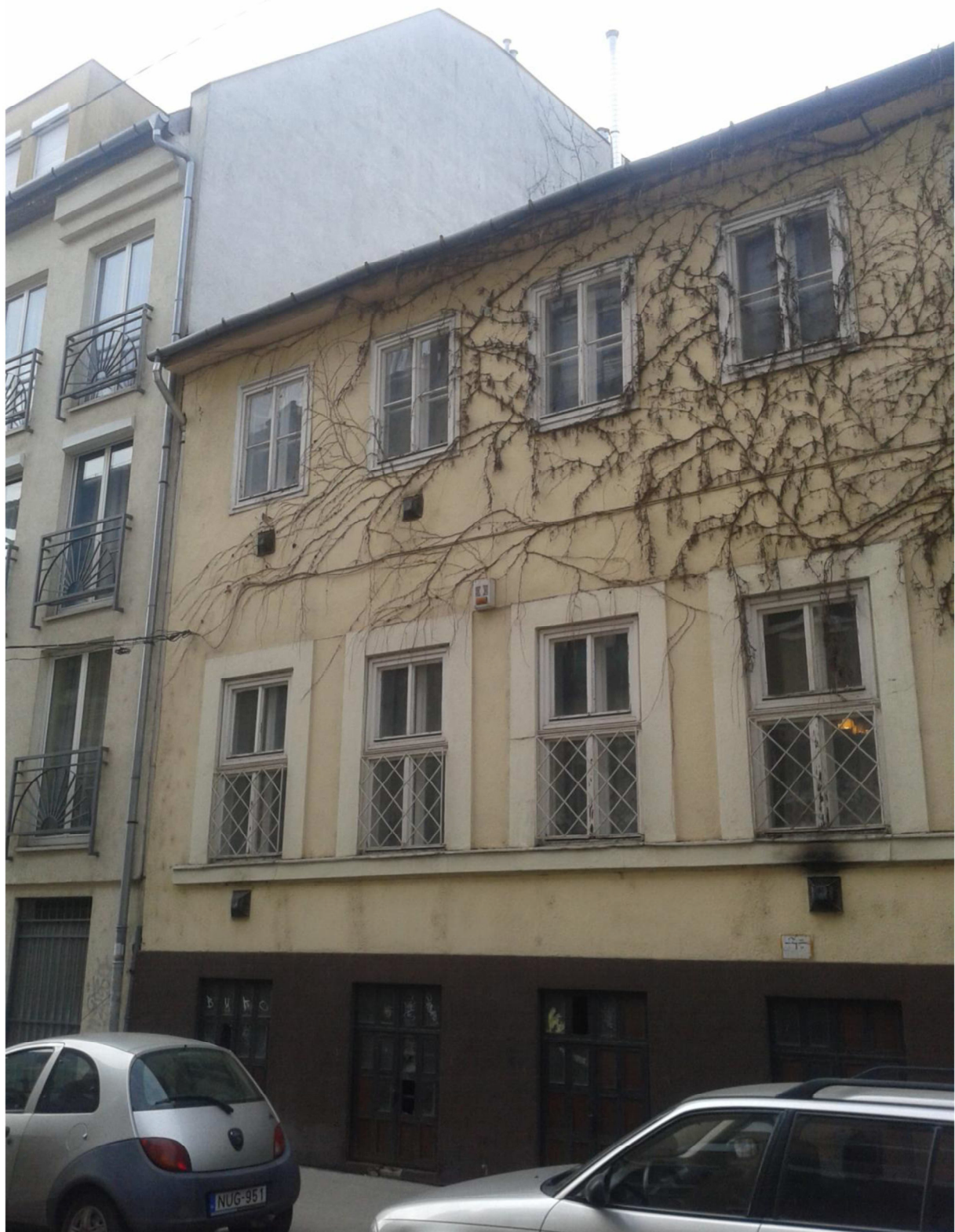
Tolnai Lajos utca 27- 25 csatlakozás
