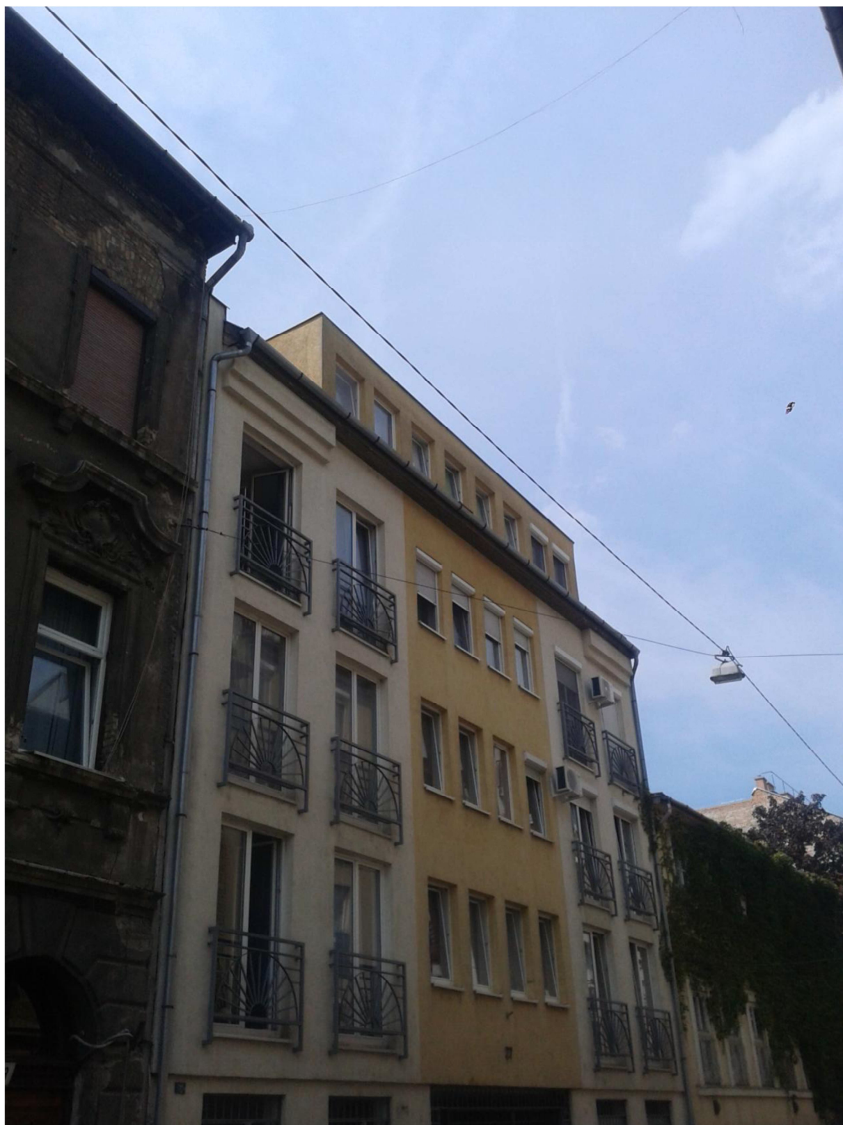
Tolnai Lajos utca 29 - 27- 25 tetőidom lépcsőzése.
