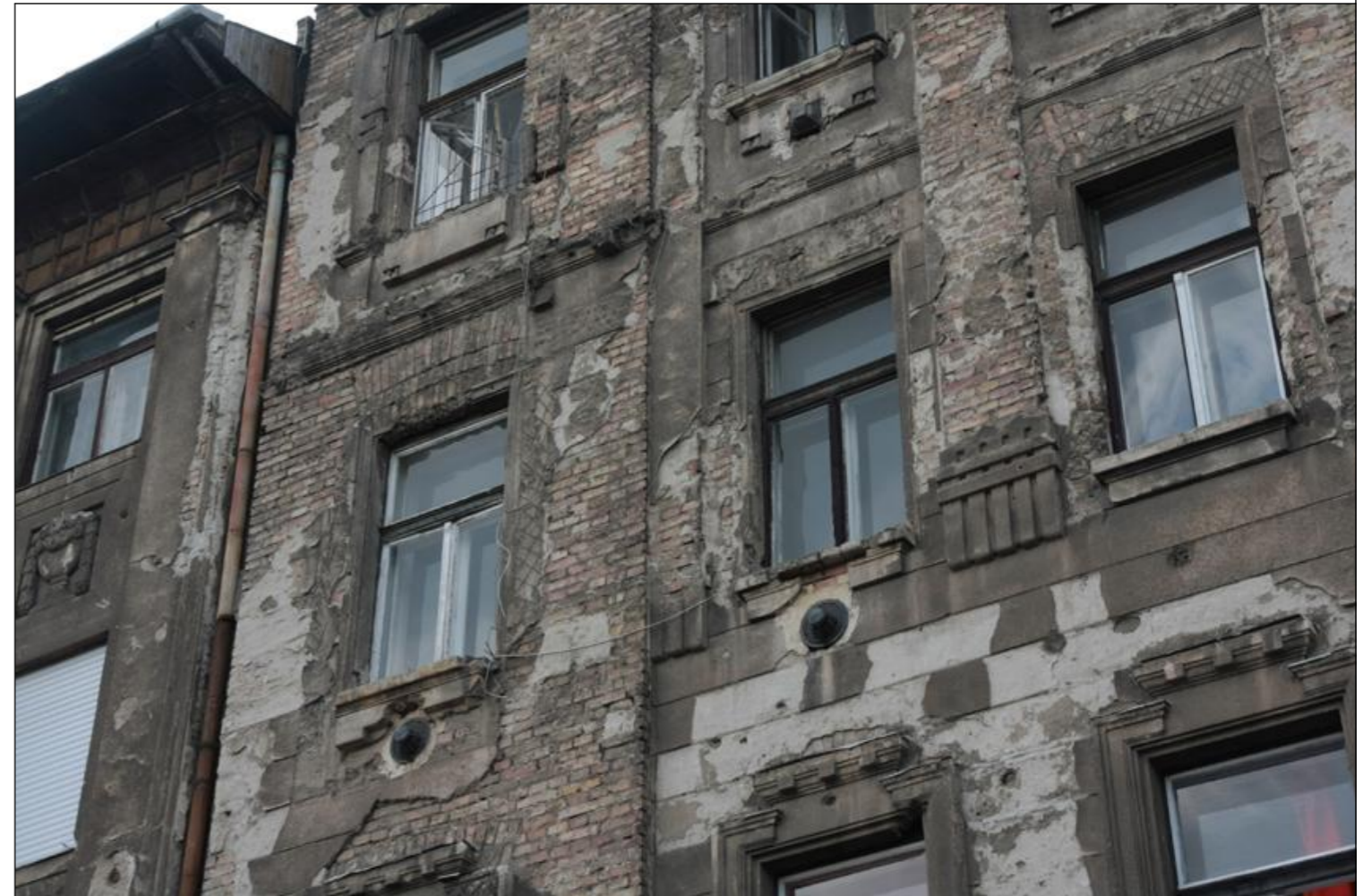
Jelenlegi állapot. Jobb oldali rizalit, 2-3 emelet.
