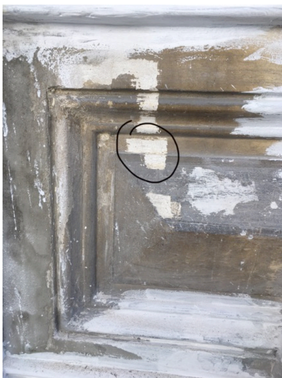
37. kép Fsz. ablakalatti keretes kváderkö. 1. mészvakolat, 2. vil. okker, 3. jelenlegi okker diszp. homl. festés, 4. elkoszolodott, látható felület
