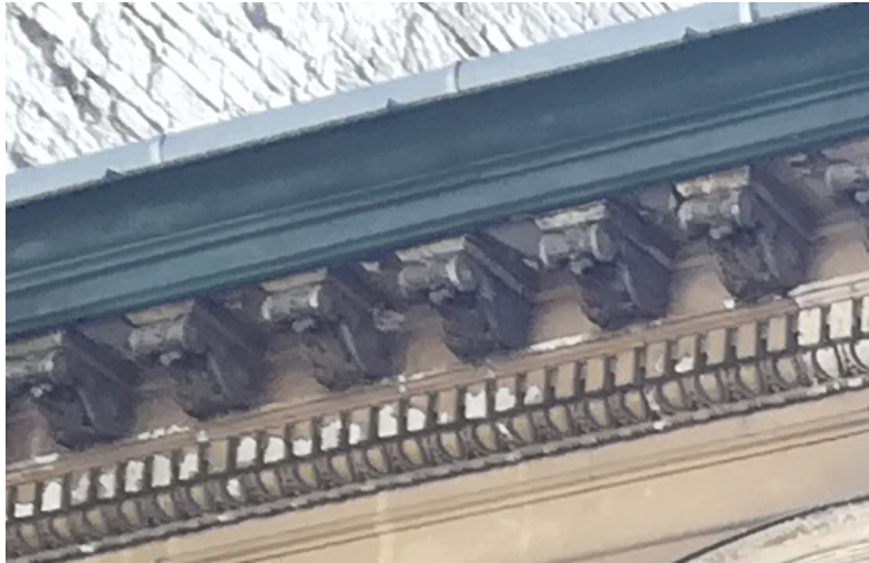
43. kép Eresz, főpárkány deszkázata.
