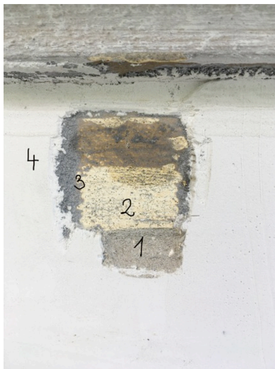
7. kép A húzott profilok, kváderkő és ablak keretezések anyaga: 1. mészk-vakolat, 2-3. okker, 4. felső, simító anyagok
