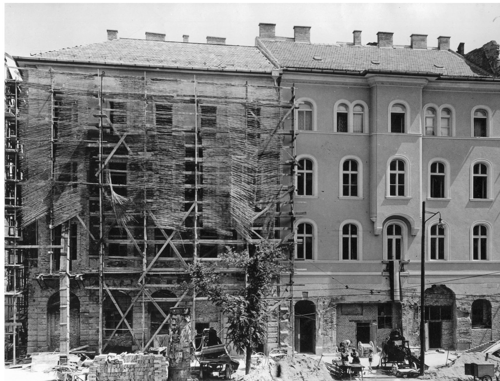
"Új" homlokzat az '56-os helyreállításokat követően
