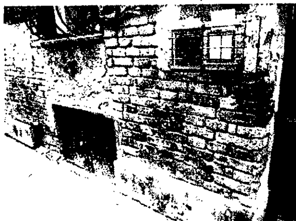
04. tégláig lehullott vakolat
