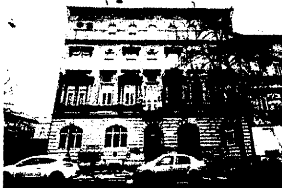
A társasház utcai homlokzata
