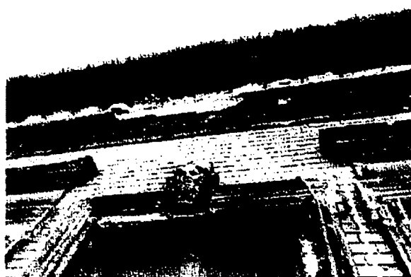
05. tető alatti deszkázat
