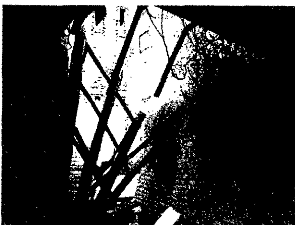
14. leomlott falszerkezet, beszakadt földém
