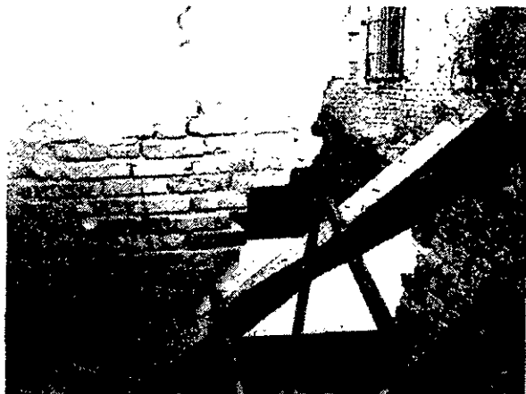
12. leomlott falszerkezet
