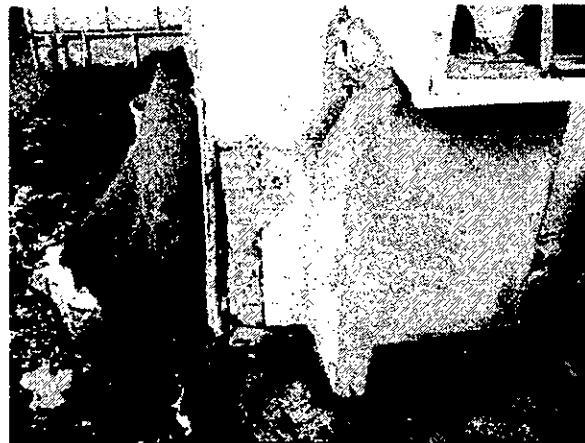
09. utólagos szigetelés a falszerkezeten
