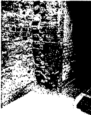
Hiányos, elfagyott lépcsőházi falpillér és málló mészkövek a tűzfalban - javítandó
