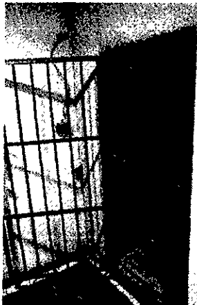
06. feljáró a 17. emeletre
