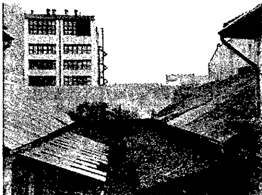
1. fénykép Raktárépület hullámpalafedése vadszölővel
