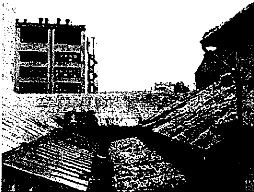
9. fénykép Raktárpépület hullámpalapafedése vadszölővel
