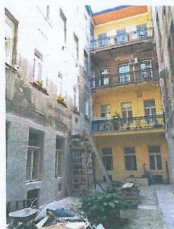
07. felújítás alatt álló belső homlokzat
