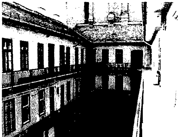
07. belső homlokzat, héjalás
