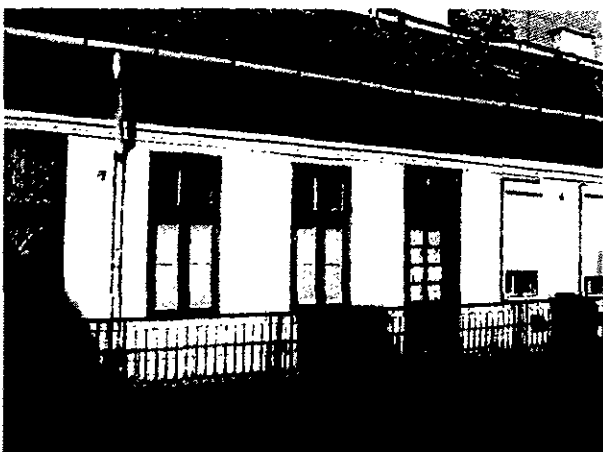
08. lakás bejárata, homlokzati nyílászárói
