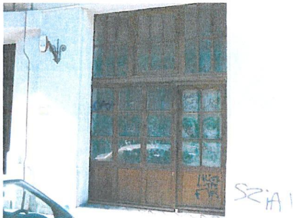
06. homlokzat, lábazat, üzlet bejárata
