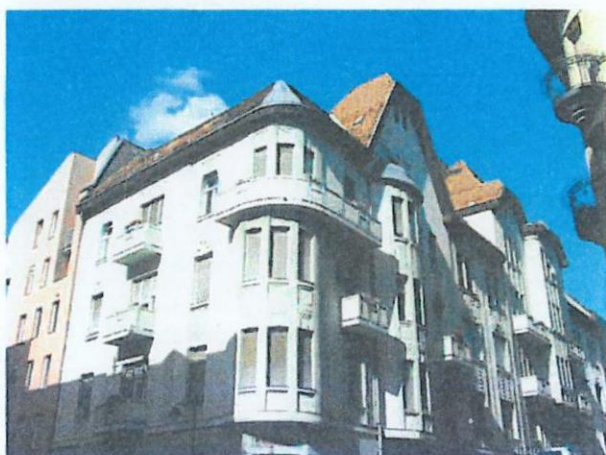
02. utcafronti homlokzat, tetőszerkezet
